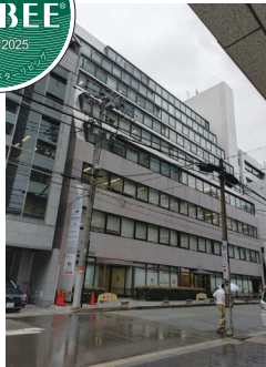
2025年10月 道修町ビル
